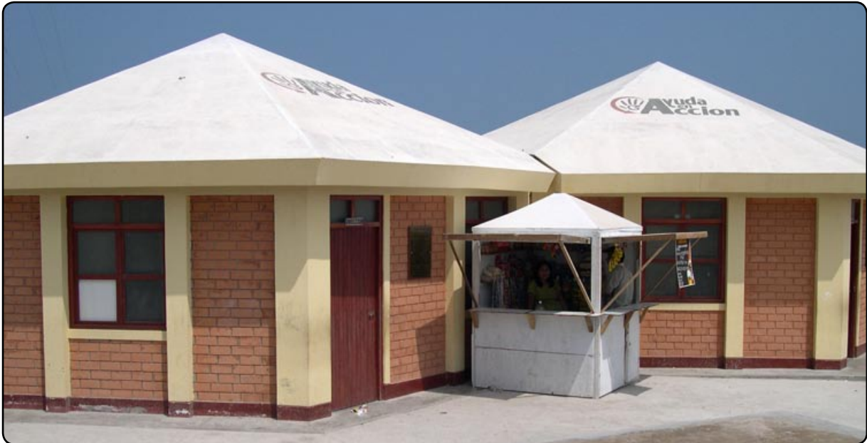
Aulas construidas en Caravelí, Perú, año 2002.
