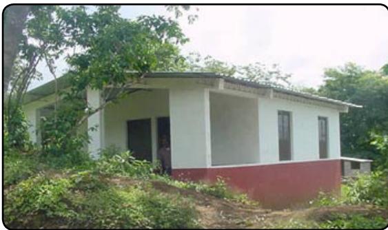
La reconstrucción de 60 viviendas y una casa comunal en la comunidad de las Conchas, gravemente afectada por los terremotos que sacudieron El Salvador en enero y febrero de 2001.
