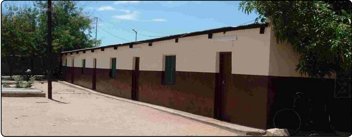
Construcción de un Centro de Acogida para niños huérfanos a causa del Sida en Tete, Mozambique, año 2005.
